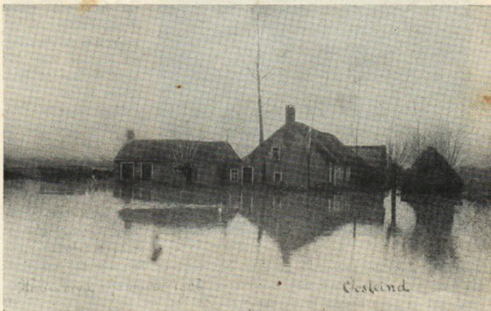
1 Januari 1926 was de Kade van de Donge bezweken in de buurt van de Hoge Dijk, waar- door een overstroming ontstond, waarvan bovenstaande foto een duidelijk beeld geeft
