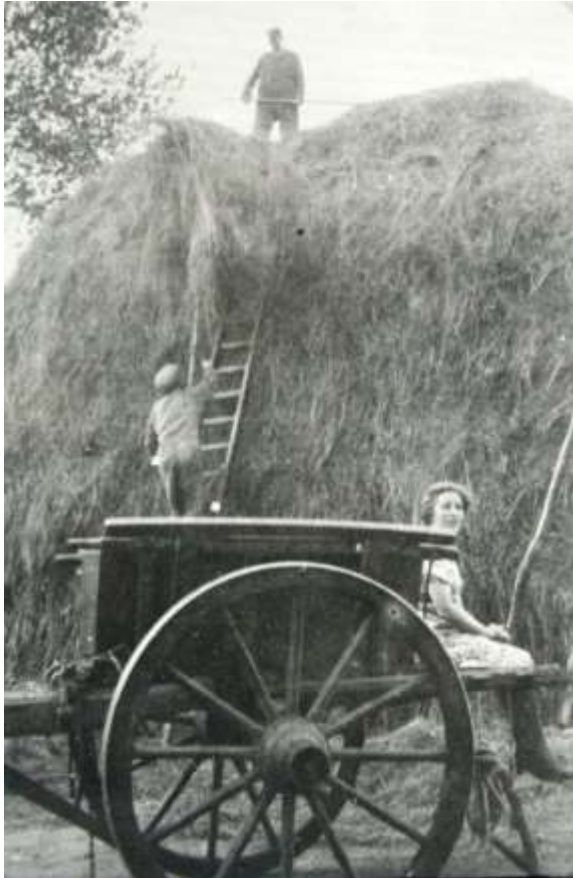
K 60 Het bouwen van een hooischelf. Op de schelf is Keesje van Strien; de opstecker is Philippus Quist en op de kar zit A Dijkstra.
