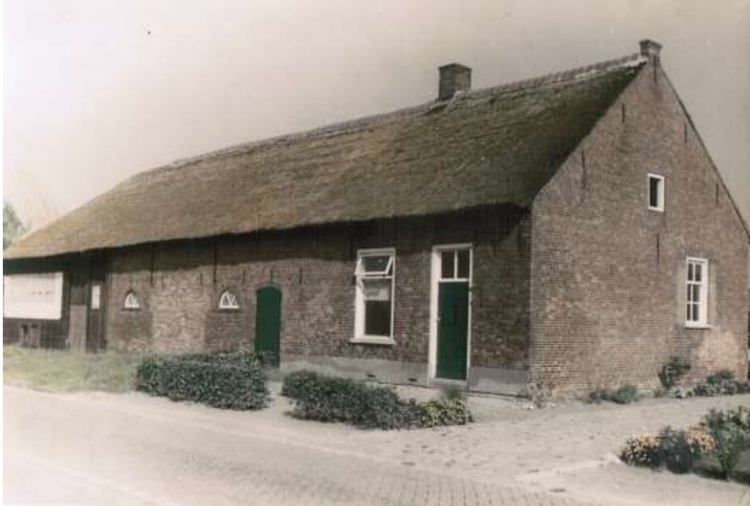
B 22 Boerderij Heistraat 3. Laatste bewoners H. vd Heijkant (Drik) en J.Huijben (koosje). Dit pand is in 1978 afgebroken. Daarna een nieuw huis gebouwd. Nieuwe bewoners C.Huijben-de Jong
