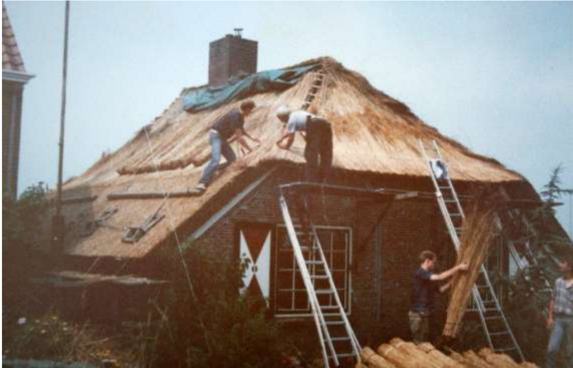
B 8 Het huis op Hoogstraat 65 wordt voorzien van een nieuw rieten dak door T. Duffhues met zijn zonen.
