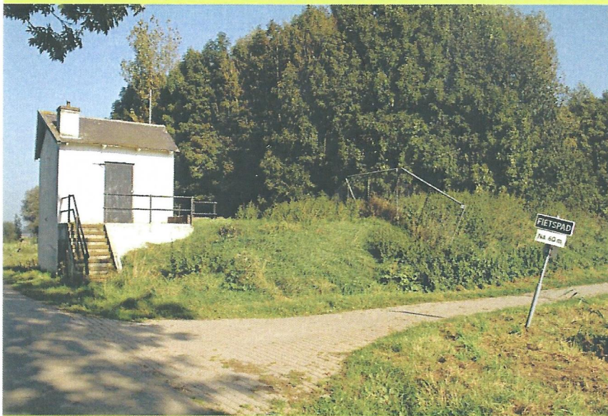
Voormalig gemaal, gebouwd in 1941 Vroeger (aan de hand van tekening van Meester A. Minjon) en nu.
